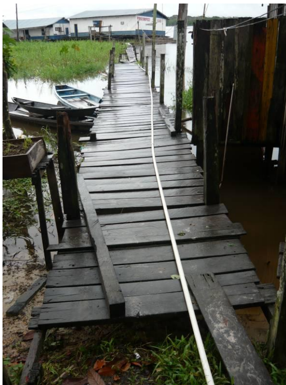
Figura 1 – Ponte de acesso ao frigorífico Tucuxi em Santo Antônio do Içá.
